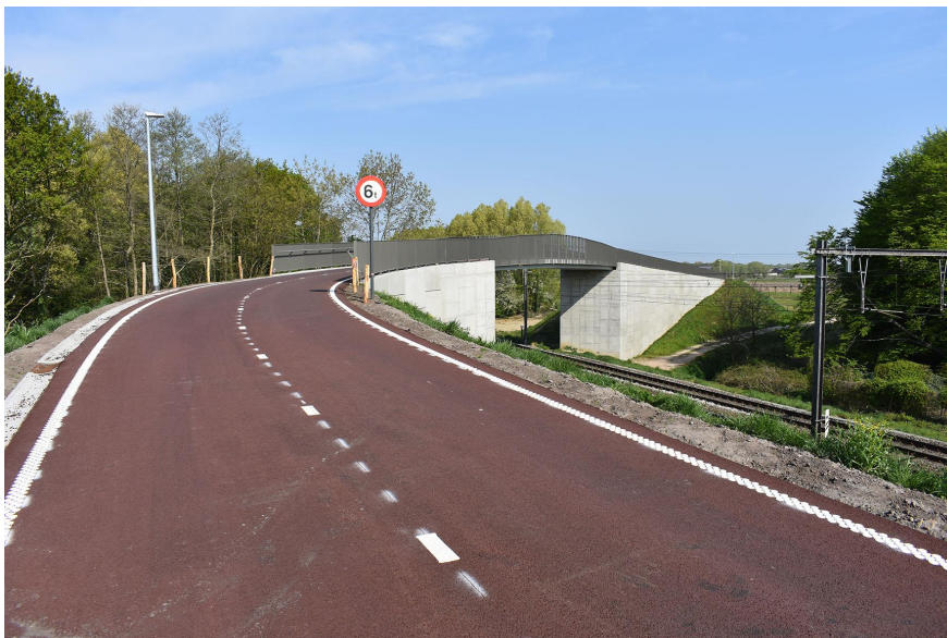
De fietsbrug op de fietssnelweg F11 over de spoorlijn 15 in Mortsel (Park Savelkoul). (foto Wikipedia)
