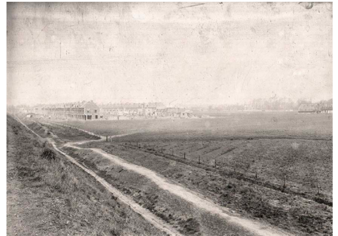
Spoorweg aan de huidige Saffierstraat (3)
