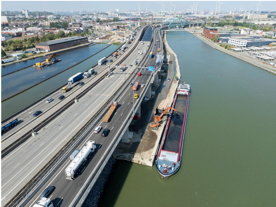
Bypass Albertkanaal: betonrecepten met minder cement. © Dronebeelden Flywel in opdracht van Lantis
